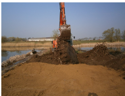
Aushub ungeeigneter Böden
