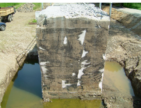
Freilegung der Tragfeiler
