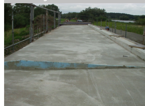
Abdichtung des Überbaus
