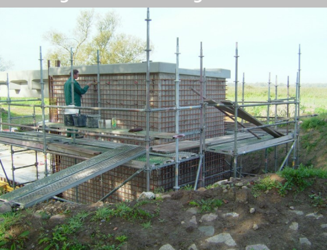
Montage der Bewehrungsmatten
