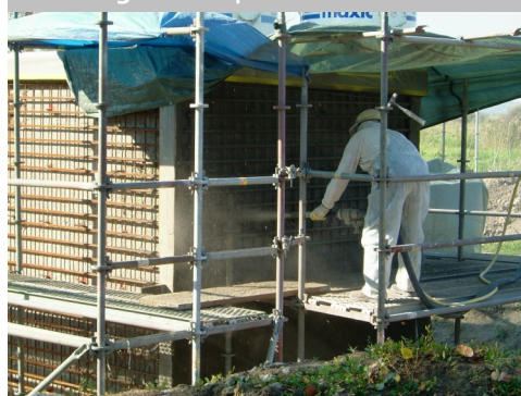
Aufbringen des Spritzbetons
