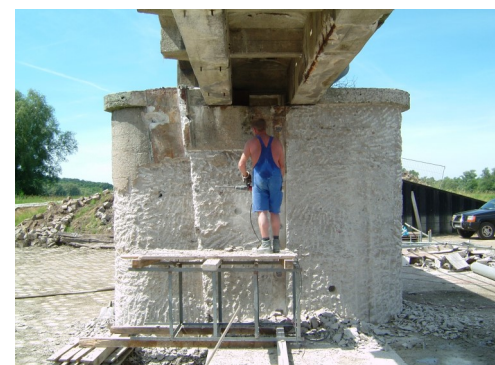
Abstemmen des Altbetons
